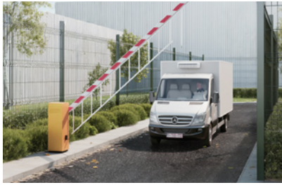
Control de acceso
