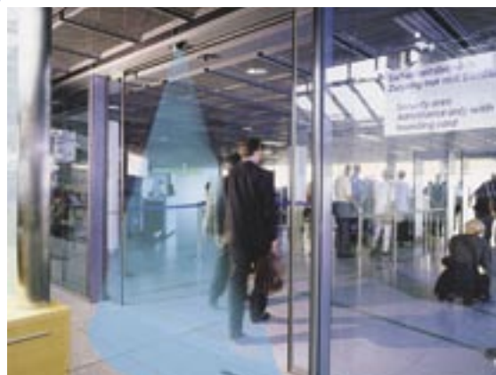
Detectieveld naargelang de zijwaartse positie van de antenne Montagehoogte : 2,20 m
