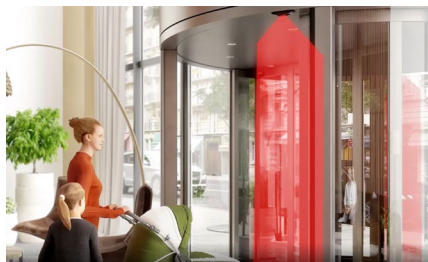
Sécurisation de la zone de pincement
